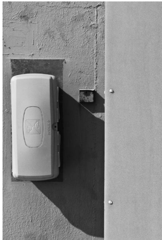
Bild oben Schutz im Offenen Raum – Feuerlöscher auf Parkdeck, 2013
