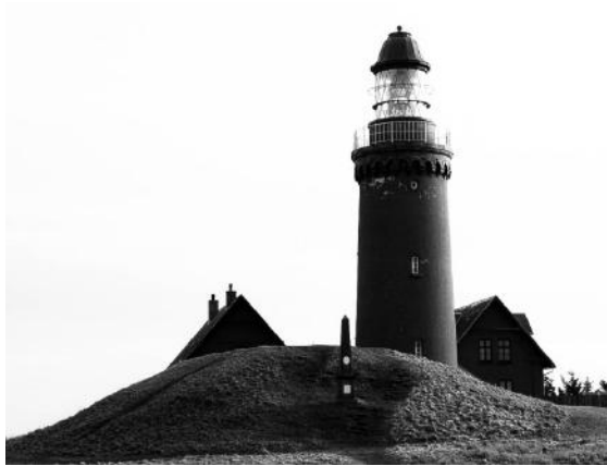
Brennt nicht mehr: Der alte Leuchtturm von Bovbjerg
